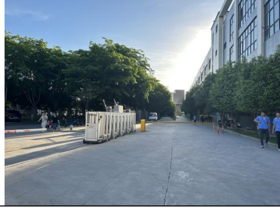
厂房南侧厂区道路
