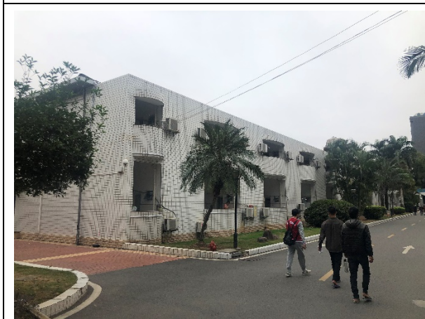
西侧2号病房楼
