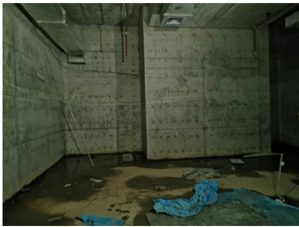
本项目直线加速器机房现状
