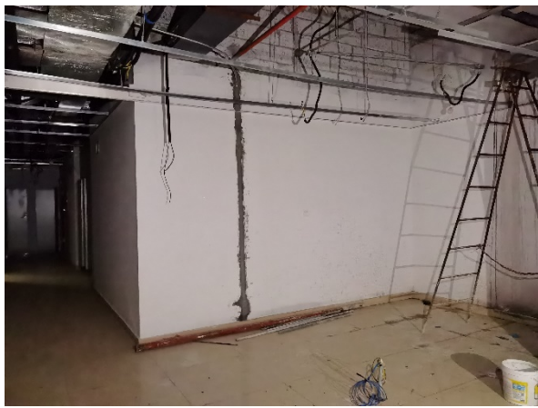
直线加速器机房南侧
