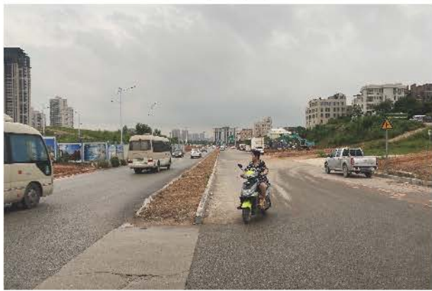
医技中心东侧杏锦路现状
