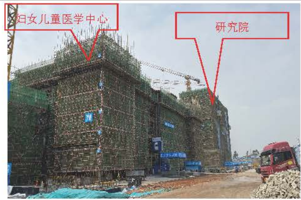
医技中心西侧拟建妇女儿童医学中心现状
