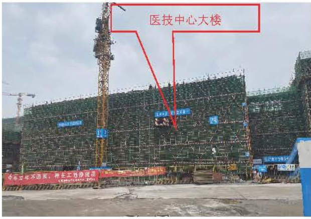
医技中心现状
