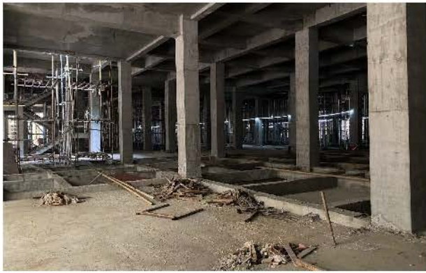
地下负一层拟建核医学科 PET 工作场所现状
