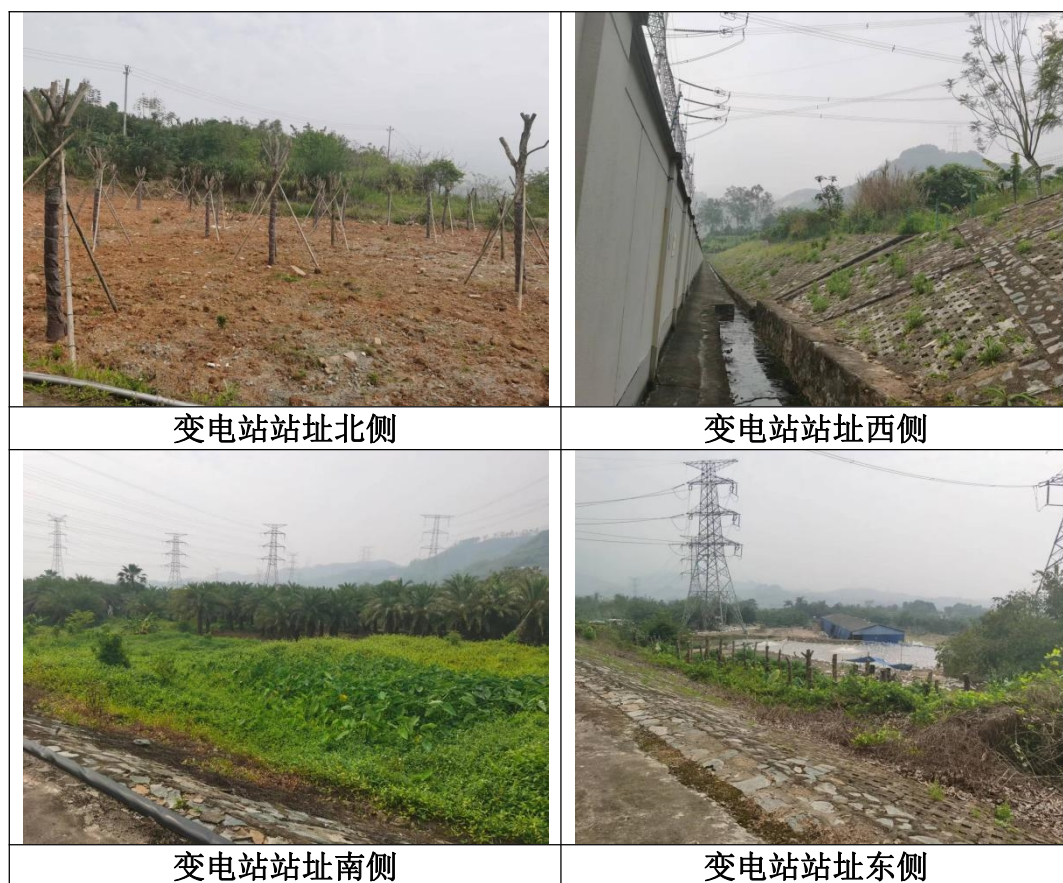
图 3.2 五峰 500kV 变电站站址四周环境概况
