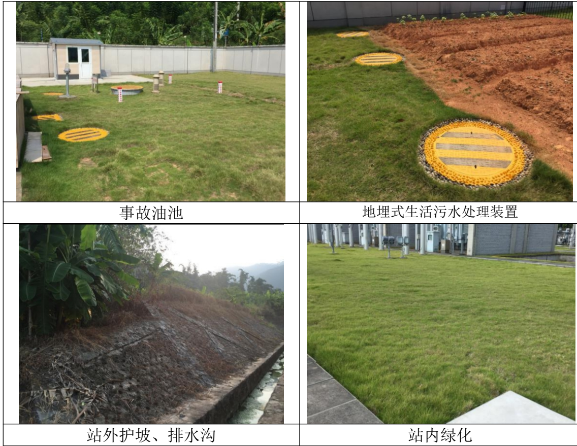
图 3.4 五峰 500kV 变电站站内现有设备及环保设施照片
