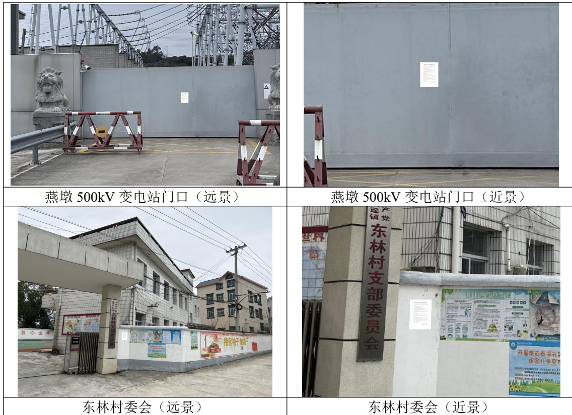
图 3.4 福建燕墩 500kV 变电站第三台主变扩建工程环境影响评价现场公示
