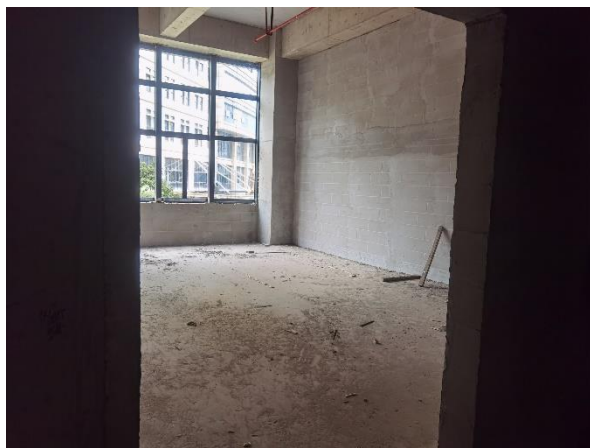
医技及门急诊楼（二期）2楼示教室 （核医学科上方）
