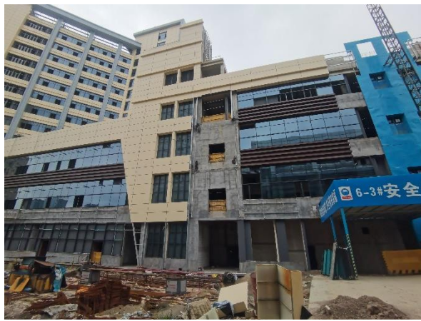
项目医技及门急诊楼（二期）现状
