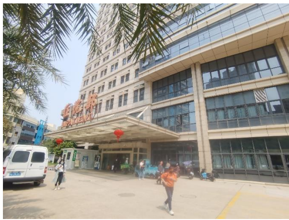
项目东侧住院部（一期）
