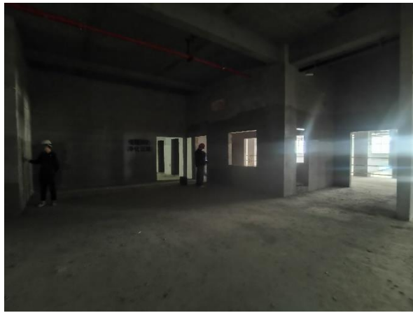
医技及门急诊楼（二期）2楼候诊室 （手术室 OR10 下方）
