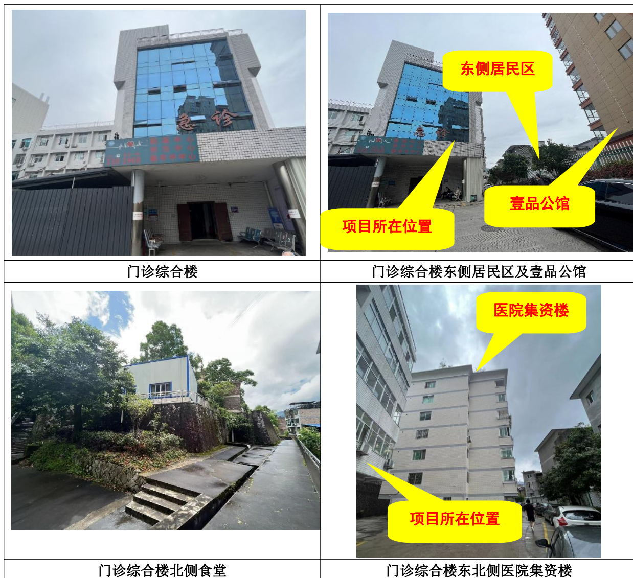
图 1.7-6 项目周边环境现状照片
