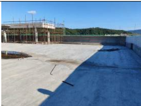
DSA 机房拟建址上方
