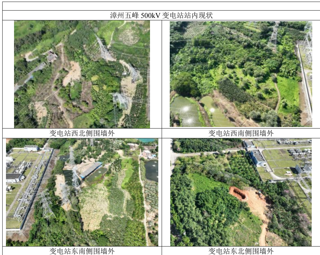
图 3-2 漳州五峰 500kV 变电站及其周边环境现状照片
