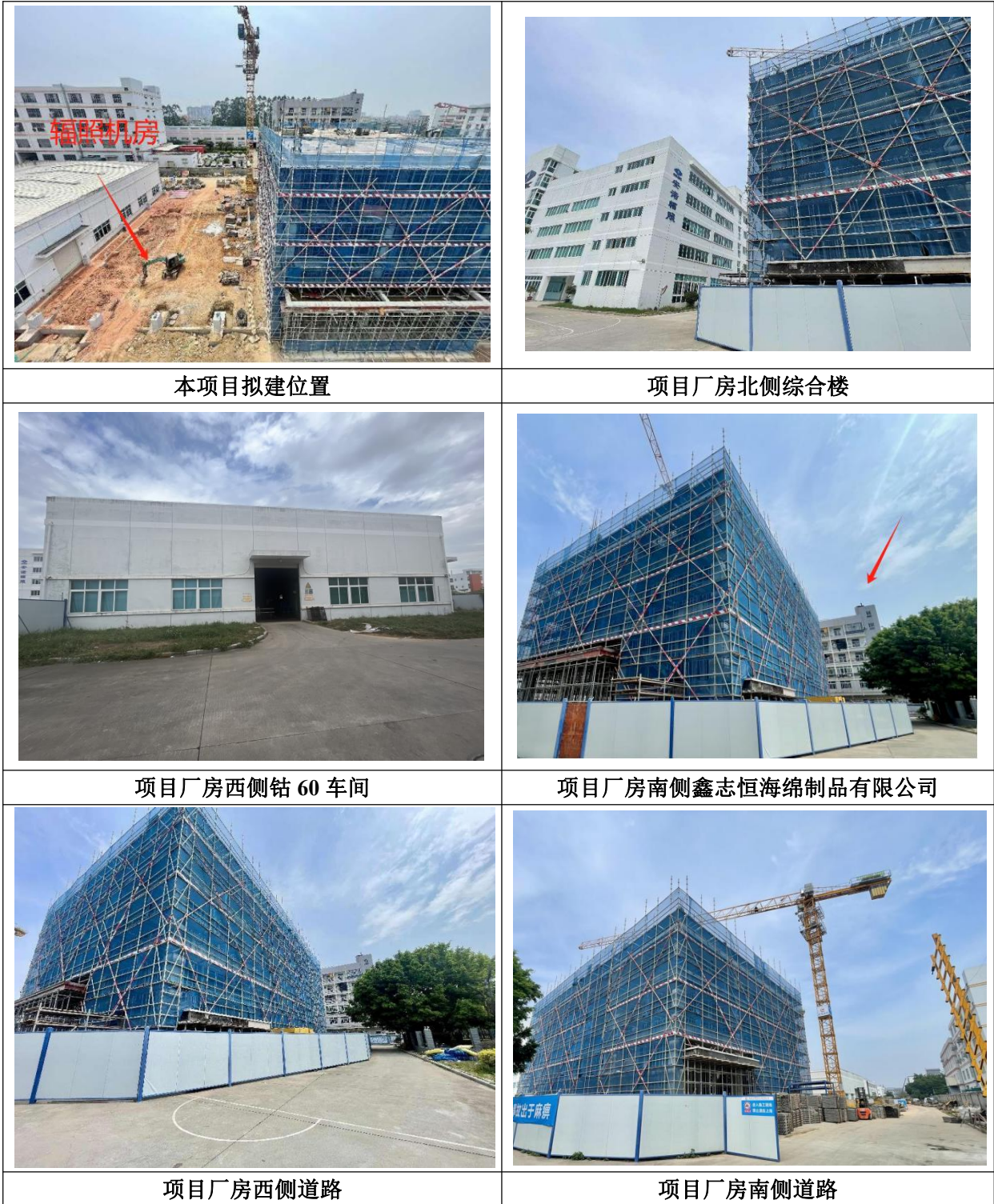
图 1.5-6 本项目周边现状照片
