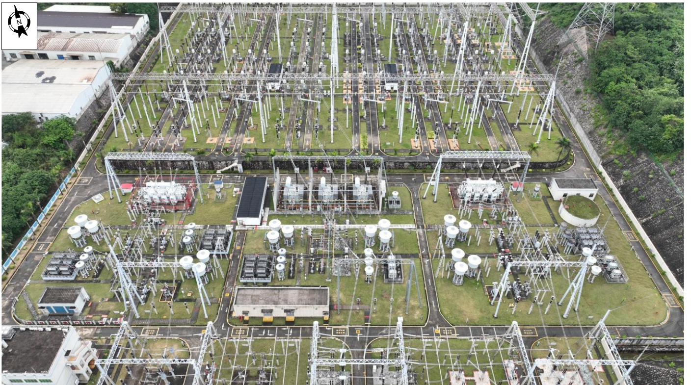
附图 3-4 500kV 福州变及周围环境照片
