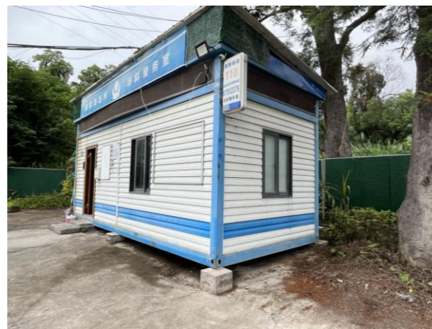
电磁敏感目标2、汤斜警务室（汤斜产业园门卫室），1F坡顶
