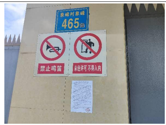
福州市晋安区新店镇象峰村福州 500kV 变电站大门处（近景）
