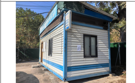
汤斜村汤斜警务室（远景）
