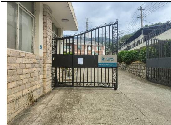
福建省电力有限公司评标基地（远景）
