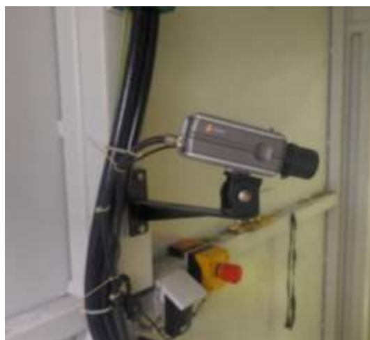
图 10-3 X 射线检测系统内部视频监控摄像头位置
