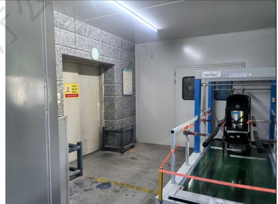
无损检测室西侧：电梯间
