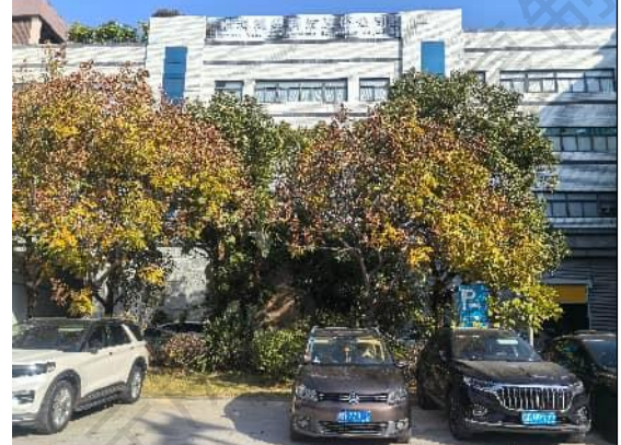
南栋厂房北侧：中庭、停车场
