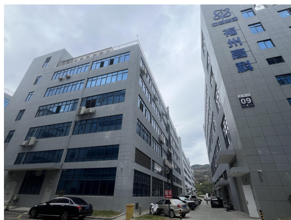
原子高科药品暂存库所在 B09 厂房及南侧道路
