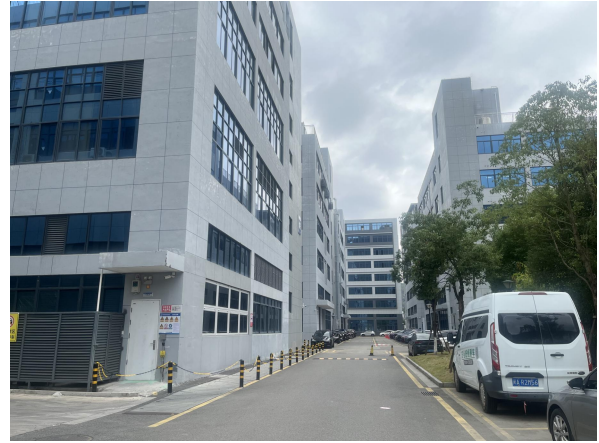
B09 厂房及北侧道路
