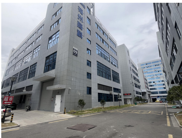
原子高科药品暂存库所在 B09 厂房及东侧道路
