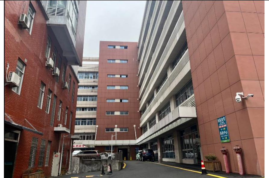
住院楼东侧——行政楼（又名感染病房综合楼）
