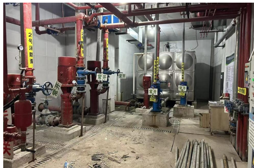
拟建DSA机房正下方现状（水泵房）
