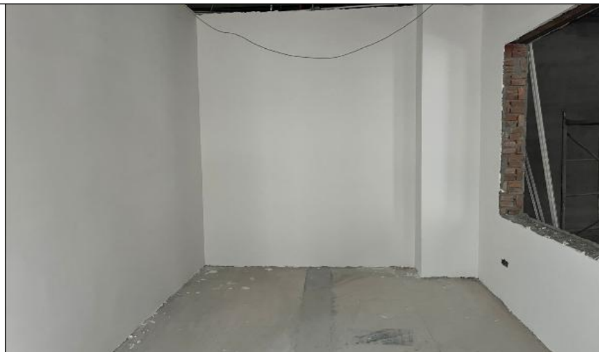
拟建DSA机房西侧现状（拟建控制室）
