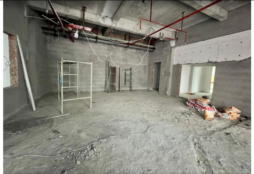
拟建DSA机房位置现状（毛坯状态）
