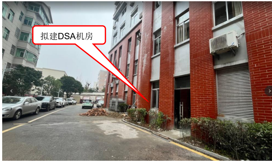
拟建DSA机房南侧（即住院楼南侧——院内道路）
