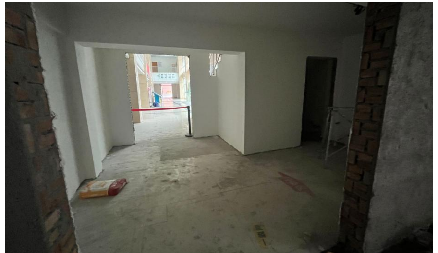
拟建DSAM机房东侧现状（拟建缓冲/换车间）
