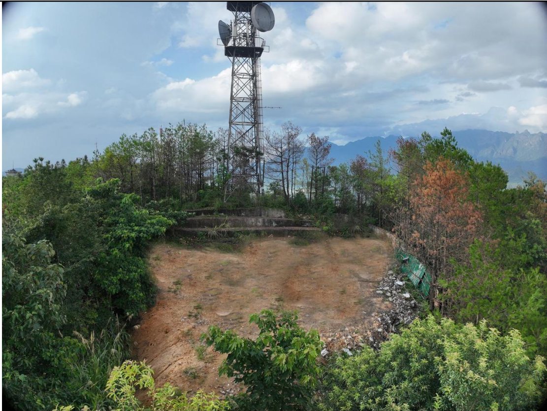
图 3.2-1 项目施工前场地现状图
