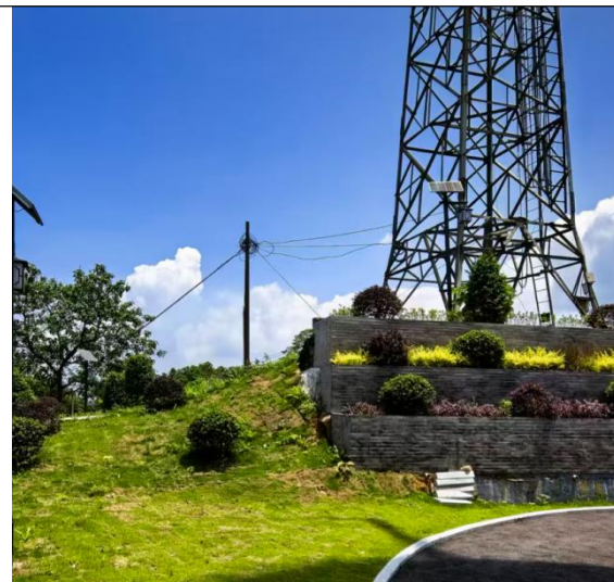
场地内的电信铁塔
