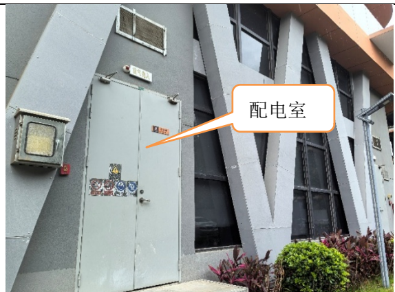
测试铅房北侧、西侧：配电室
