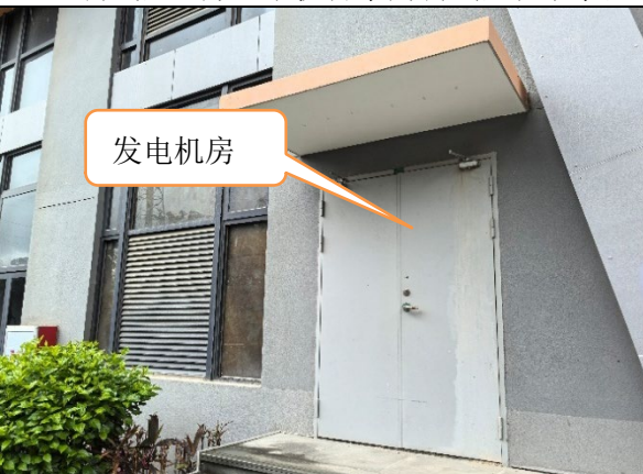
测试铅房东北侧：发电机房
