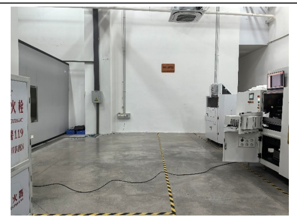
测试铅房东侧：机台组装调试车间
