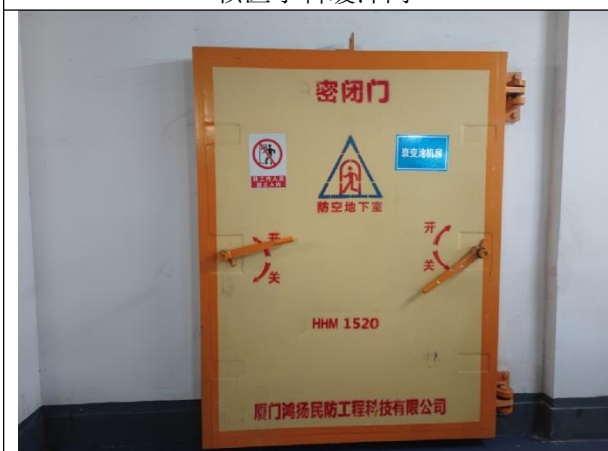
核医学科地下衰变室
