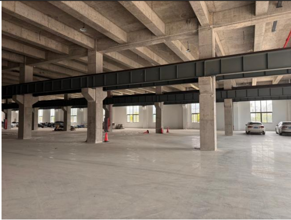
项目测试区和组装区现状
