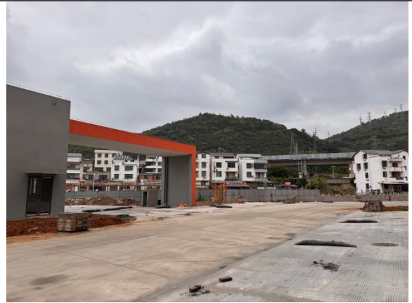
北侧厂区道路
