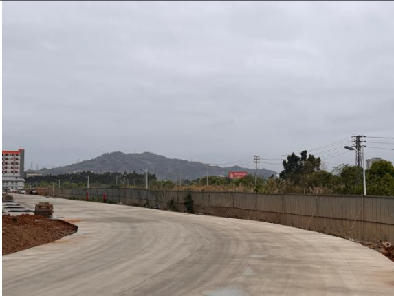
西侧厂区道路
