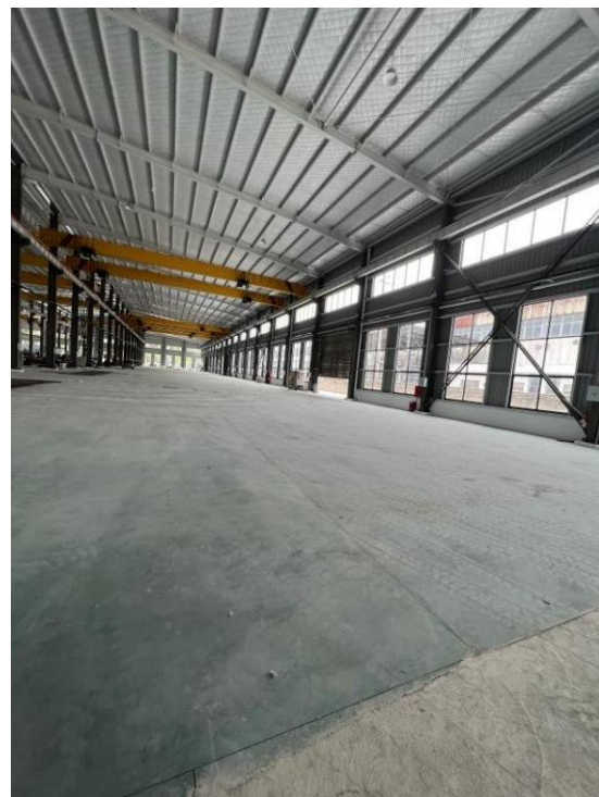
拟建探伤室西侧
