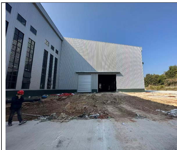
本项目探伤室拟建址
