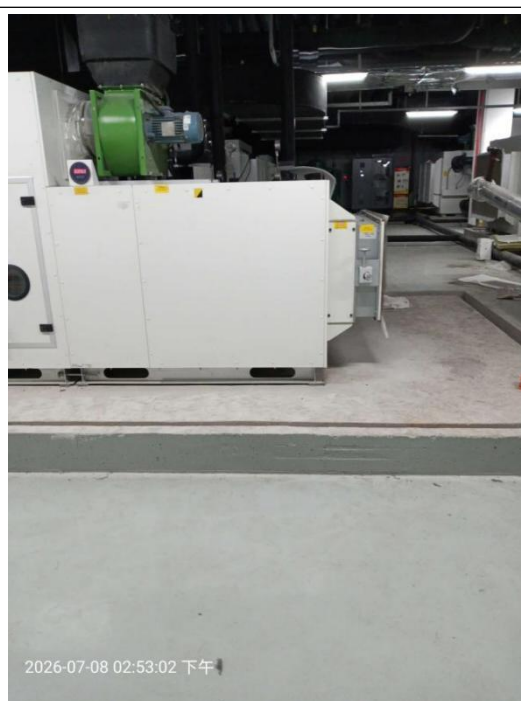
14#CT 检测区正上方
