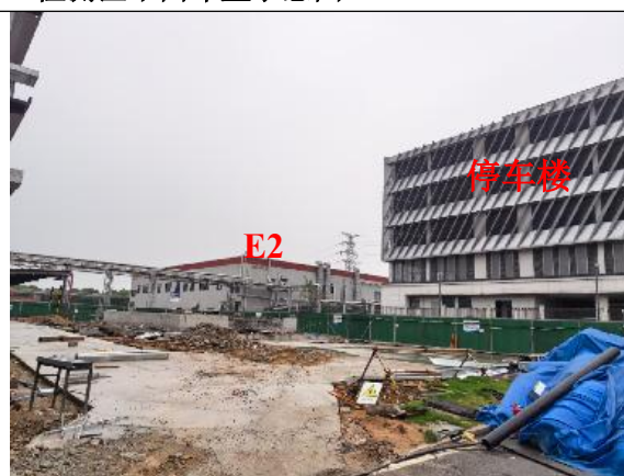
E1 厂房南侧 E2 厂房及停车楼
