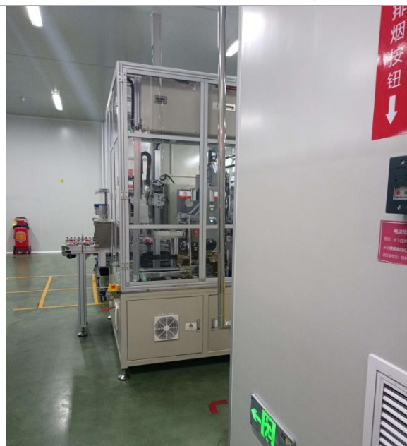
9#CT 检测区现状
