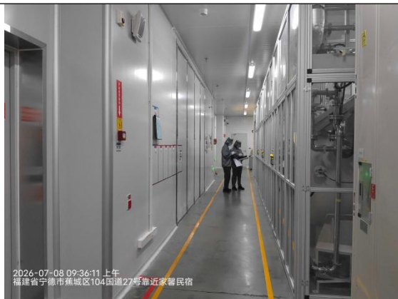
6#CT 检测区西侧过道
