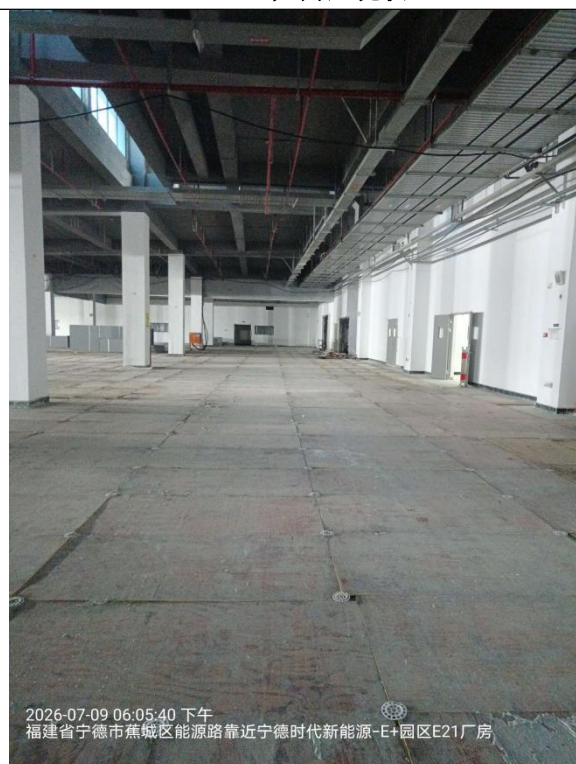
11#CT 检测区现状
