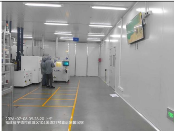
3#和 4#CT 检测区北侧过道及大干燥房
