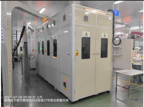
2#CT 检测区西侧生产区
