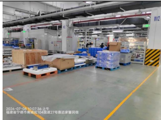
3#和 4#CT 检测区正下方生产区（设备未进场）
