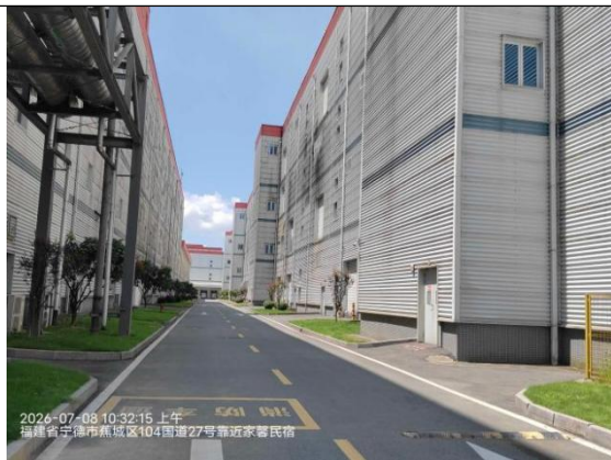
Q1 厂房东侧道路及 Q2 厂房
