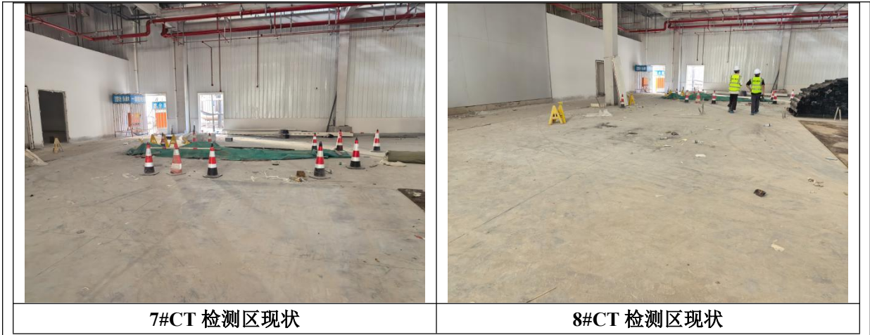
图 1.3-9 湖东厂区 E1 厂房及 CT 检测区周边环境现状照片
