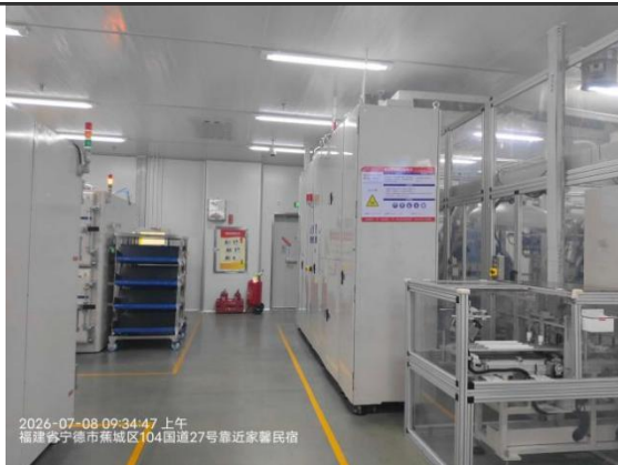
6#CT 检测区现状
