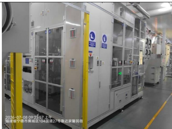
5#CT 检测区北侧生产区
