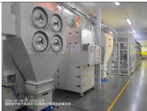
5#CT 检测区南侧生产区及过道
