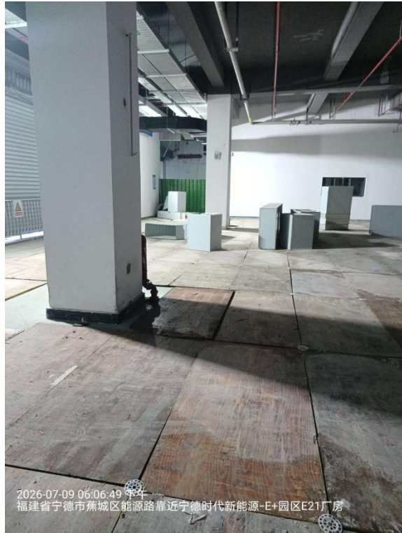
12#CT 检测区现状
