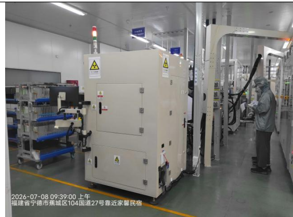
2#CT 检测区现状
