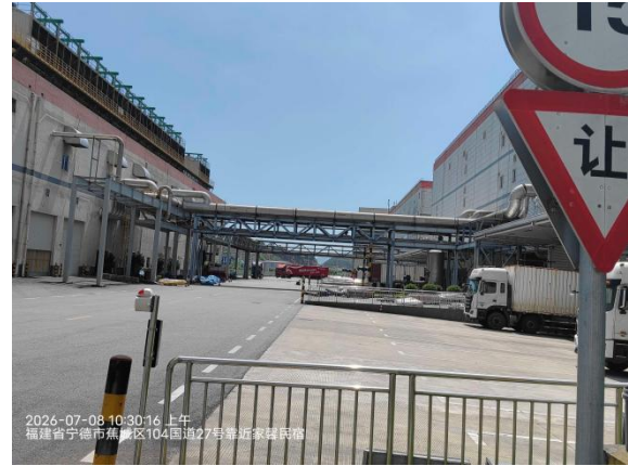
Q1 厂房北侧道路
