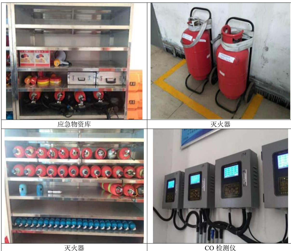
图 9.7-1 一期工程应急物资现状图
