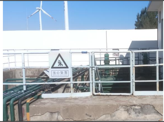
生活污水处理站
