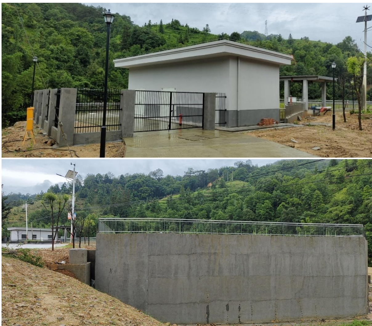
图 4.3-6 园区应急事故池建设现状
