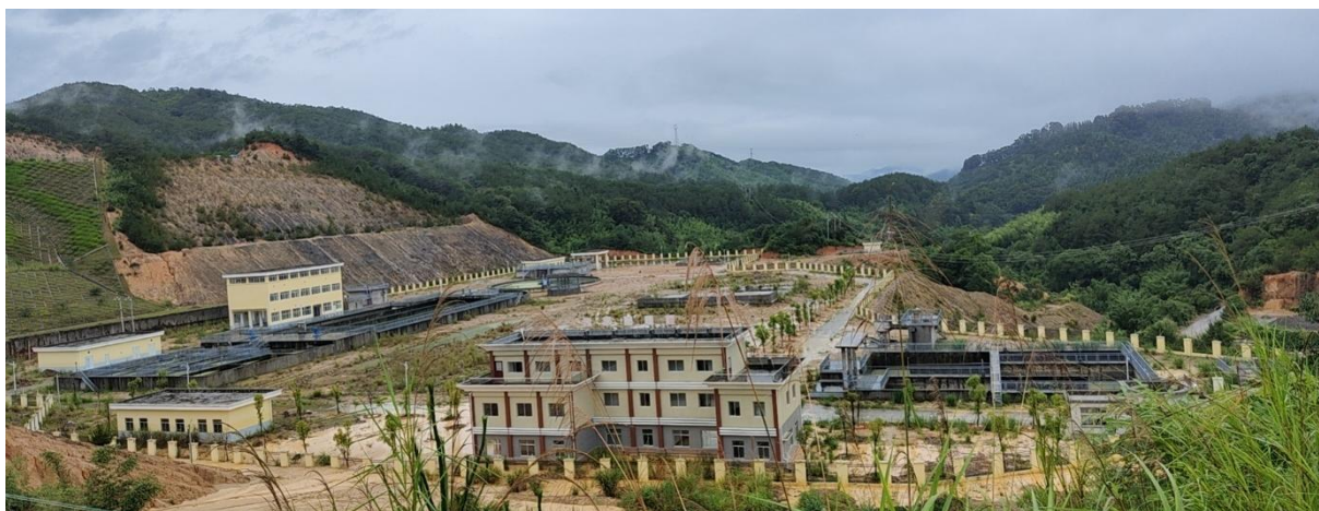
图 4.3-2 城南园污水出处理厂建设情况
