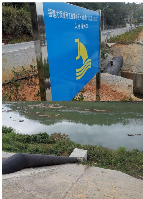
图 4.3-4 污水处理厂尾水排放口位置
