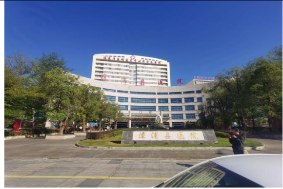
拟建 DSA 机房所在门诊综合楼
