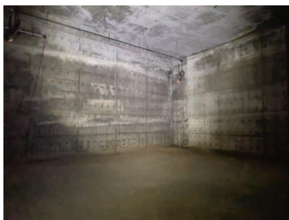
拟改建机房内部
