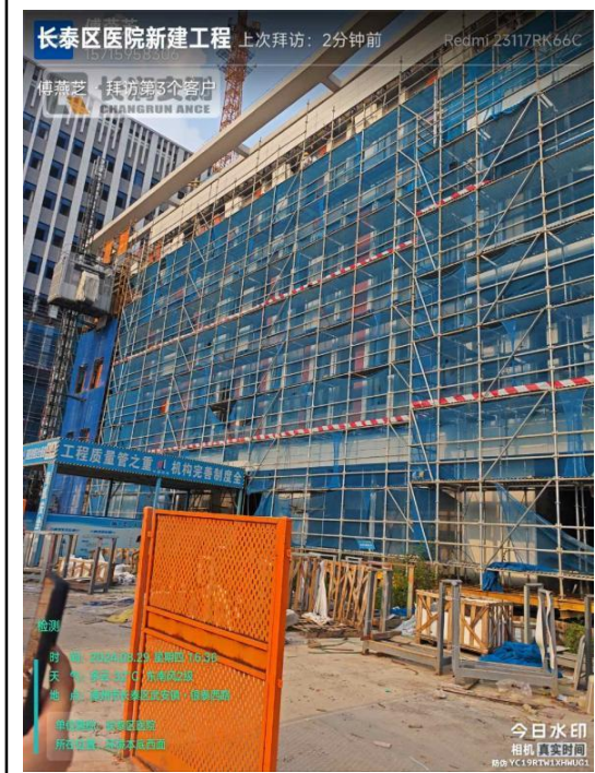
门急诊医技楼西侧
