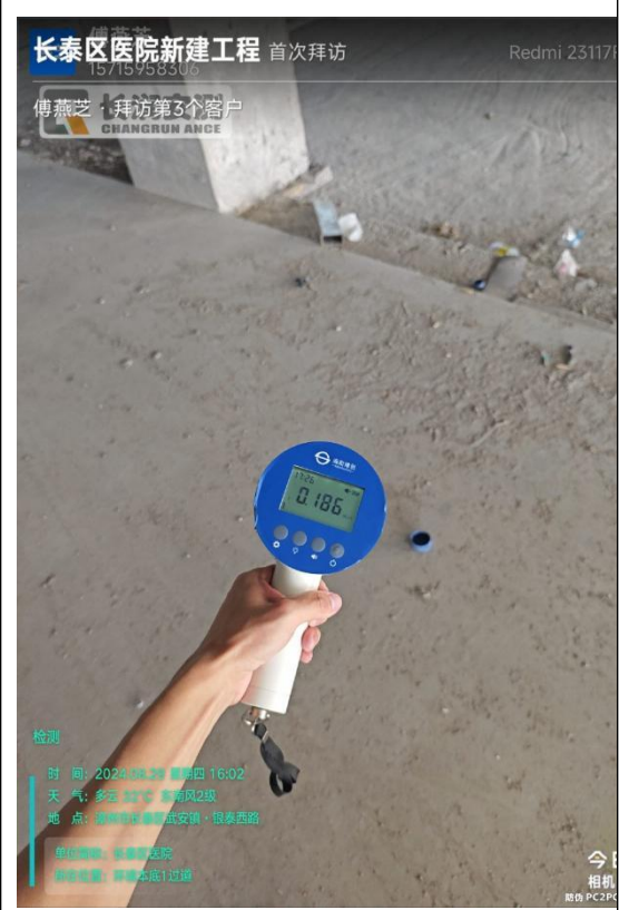
DSA 手术室北侧（走廊）
