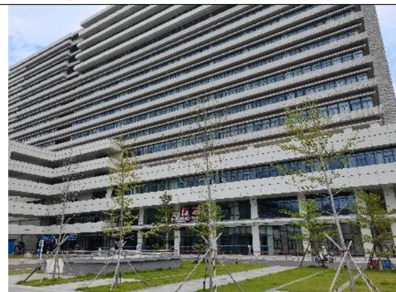
照片 1-3 门诊医技楼北侧住院楼
