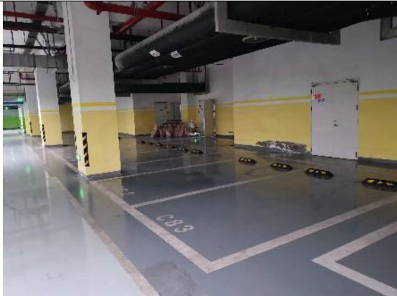
照片 1-14 拟建 DSA 机房下方地下停车场
