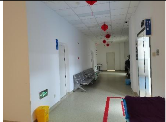
照片 1-15 拟建 DSA 机房上方通道、更衣室等
