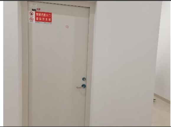
照片 1-13 拟建 DSA 机房东侧空调机房现状
