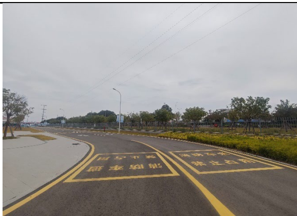
A2 厂房南侧：厂内道路
