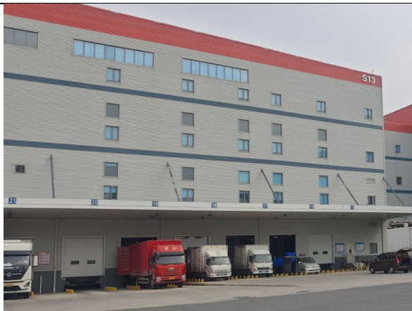
TSOL-CT225X 型工业 CT 机 所在建筑：S13 厂房
