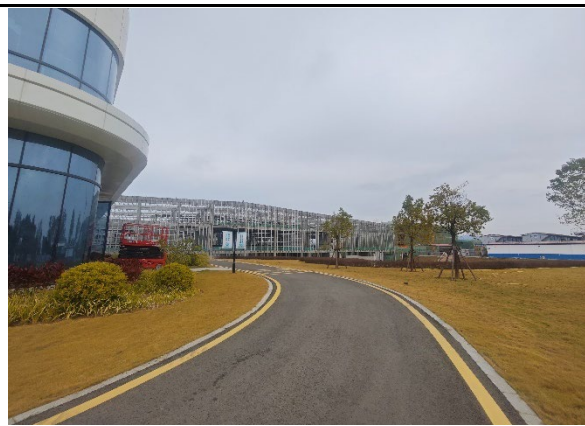
A2 厂房东侧：厂内道路
