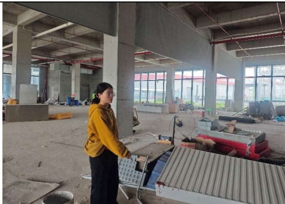
CT 测试室西侧：干燥房（待建）
