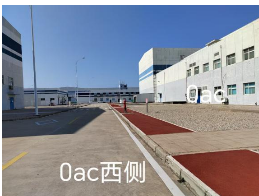
0AC 厂房西侧
