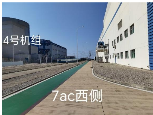
7AC 厂房西侧
