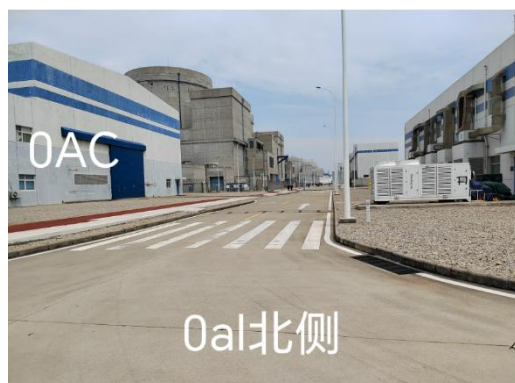
0AL 实验楼北侧
