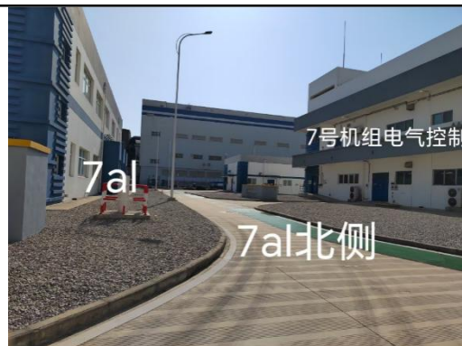
7AL 实验楼北侧
