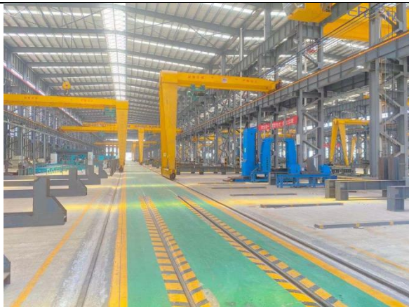
典型现场探伤工作场所-钢结构厂房
