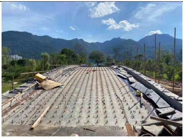
典型现场探伤工作场所-桥梁
