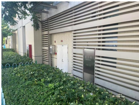
楼外拟建 PET/CT 放射性废水衰变池位置现状
