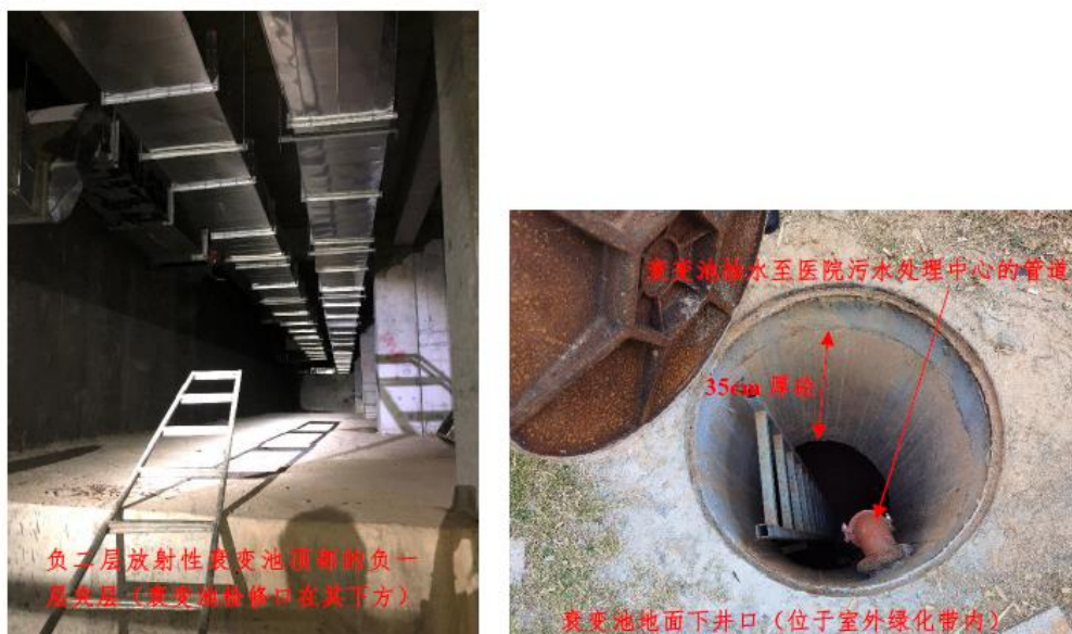
图10-3 核医学科在用衰变池现状
