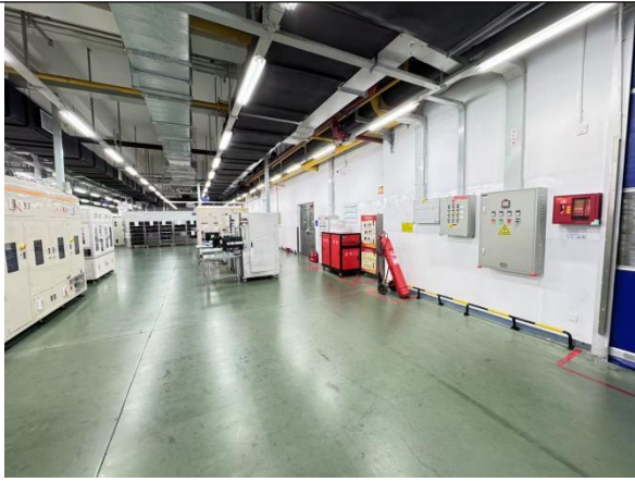
设备拟安装位置
