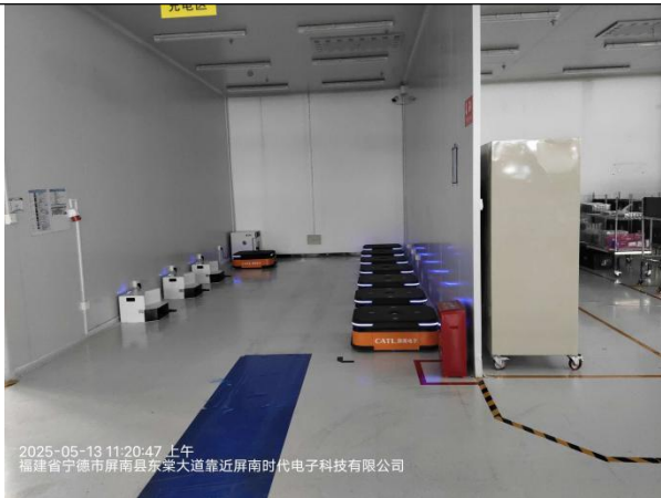
西北侧 AVG 充电区
