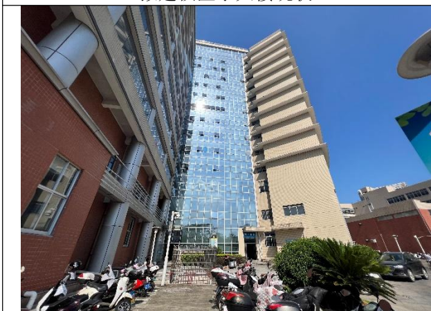
拟建核医学大楼东侧道路及住院楼
