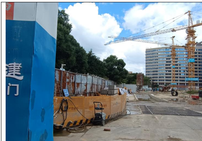
拟建核医学大楼现状
