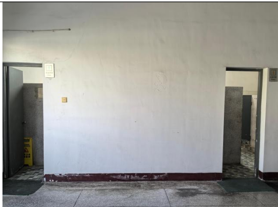
X 射线检测室南侧：卫生间
