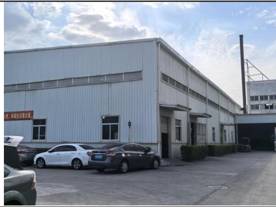
107 号厂房西侧：机加工厂房
