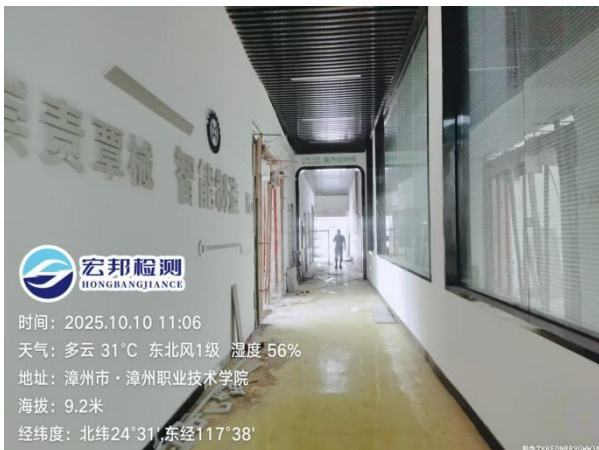
北侧（楼内过道）
