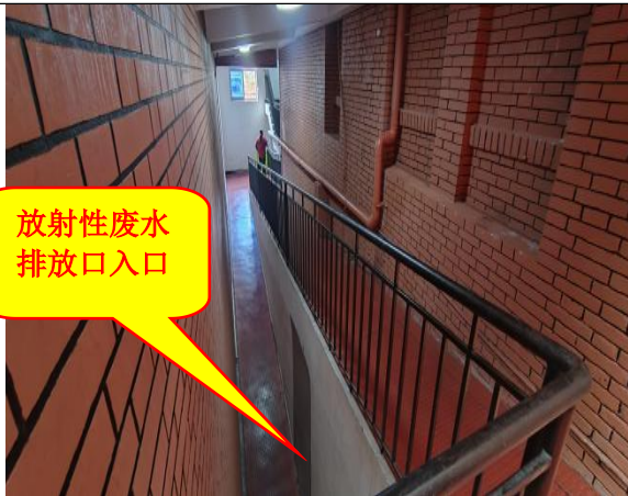
1 号楼核医学科衰变池上方人行通道
