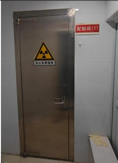
①高活性室配制间 1 入口防护门
