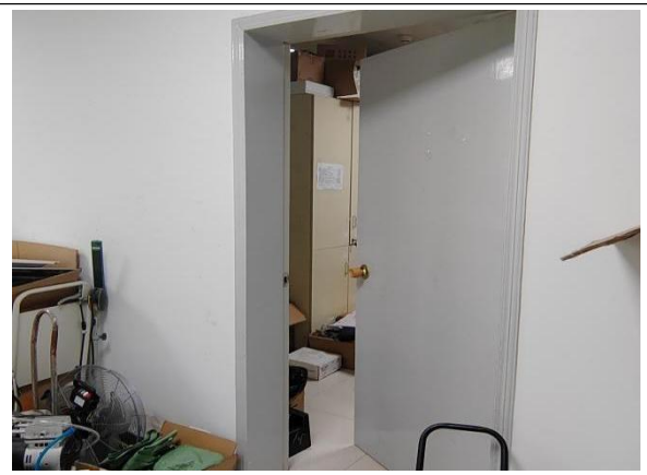
1 号楼地下一层后勤保障部仓库 （候诊室下方）
