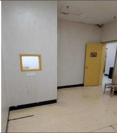
1 号楼一层核医学科 ^{90}\text{Sr} 治疗室
