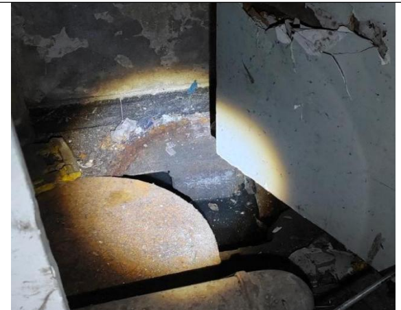
1 号楼核医学科衰变池废水取样口
