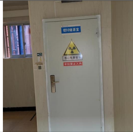
⑧ 90 Sr 储源室防护门
