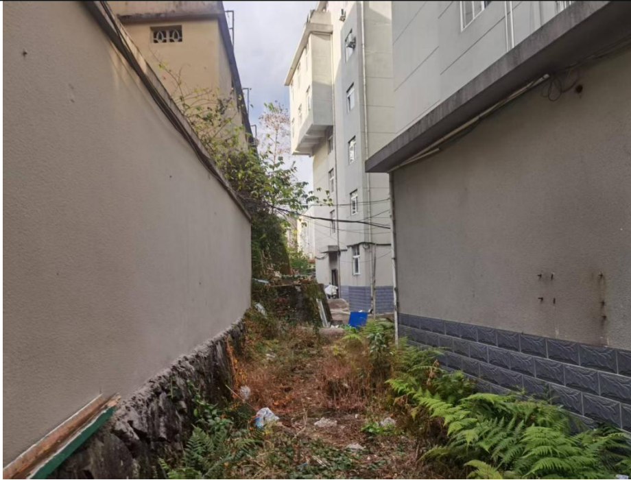
医技楼西侧围墙内（通道）
