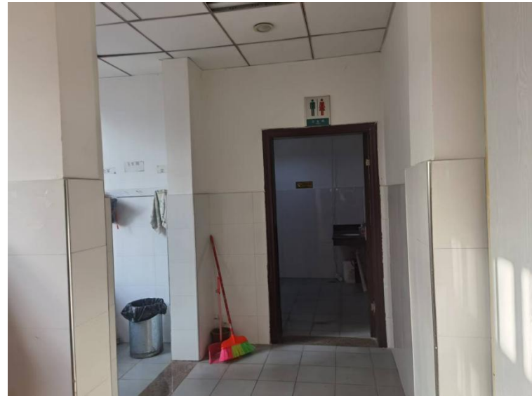
拟建DSA机房正上方现状（卫生间、洗涤间）
