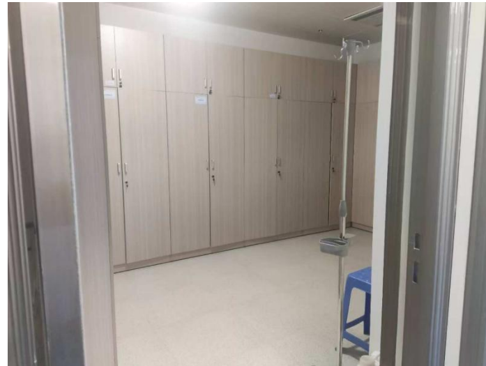
DSA2 机房东北侧导管室
