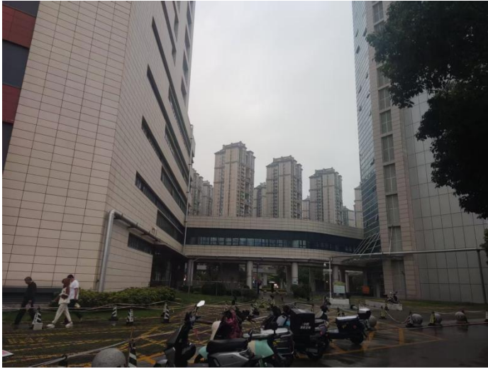
同心楼与病房楼之间连廊
