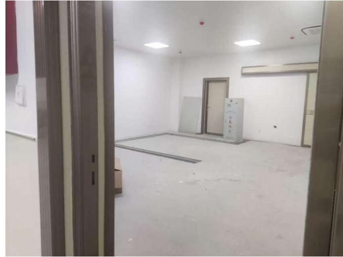
DSA2 机房东南侧预留 DSA1 机房
