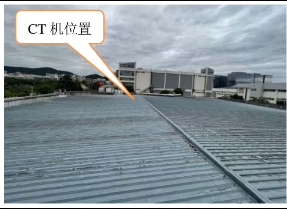
一期厂区一期生产车间屋面
