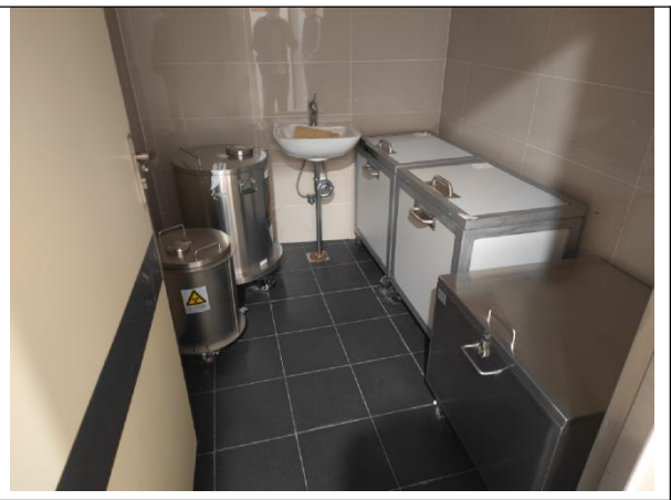
核医学科危废暂存间
