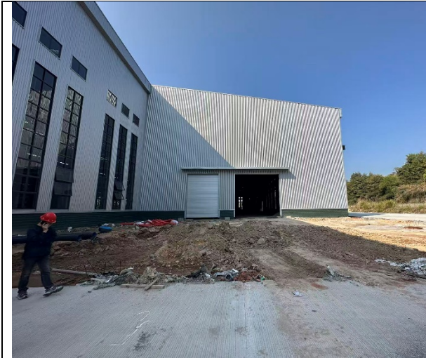
本项目探伤室拟建址
