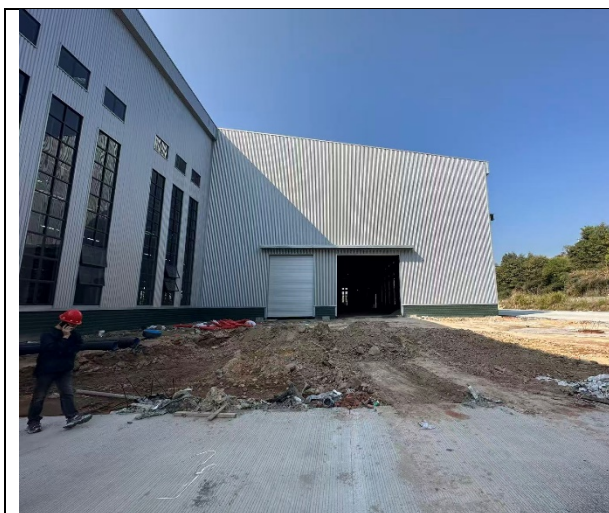
本项目探伤室拟建址
