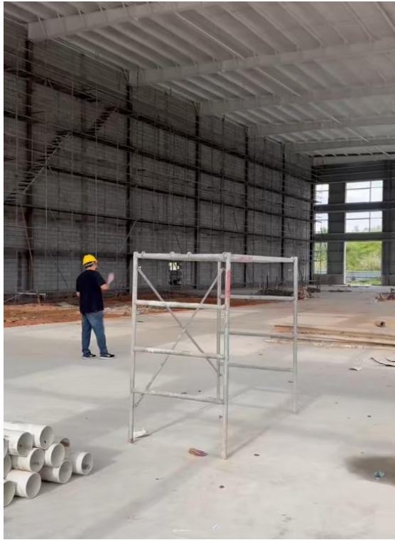
建设单位厂房现状
