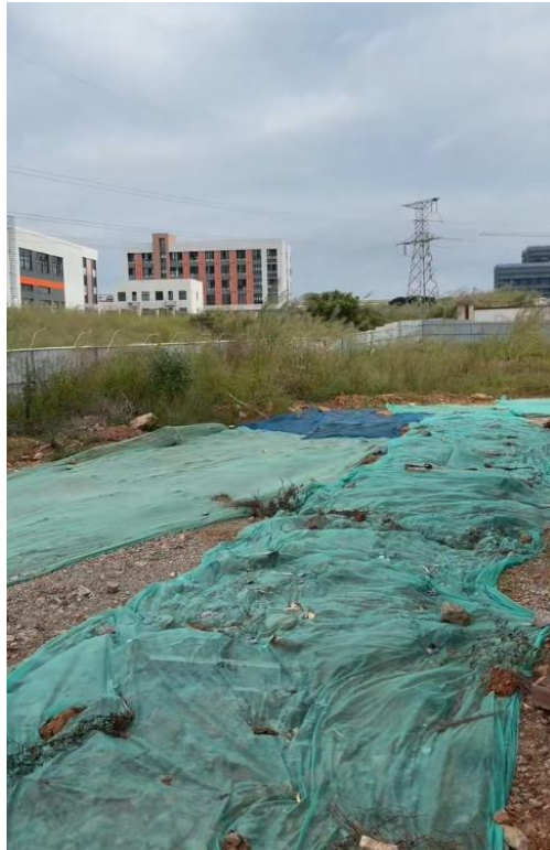
建设单位厂房东侧现状
