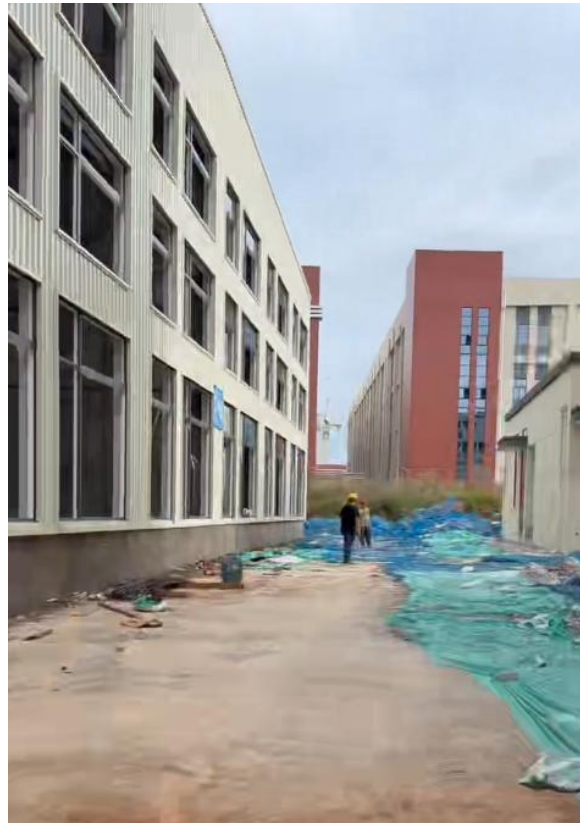
建设单位厂房西侧现状
