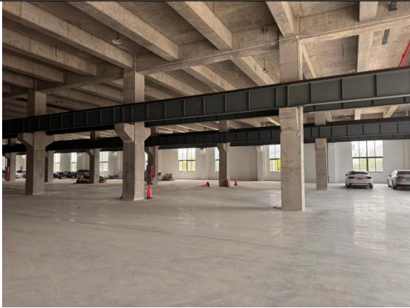
项目测试区和组装区现状
