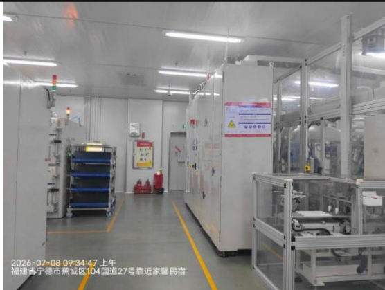
6#CT 检测区现状
