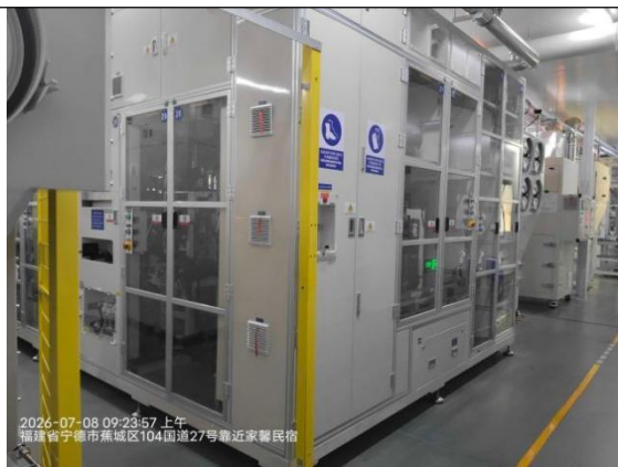
5#CT 检测区北侧生产区
