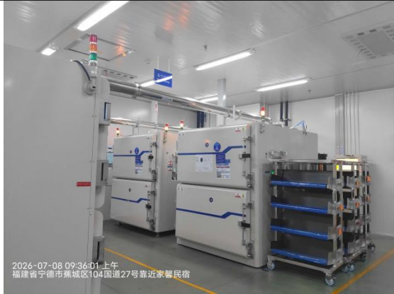
6#CT 检测区南侧 Baking 区
