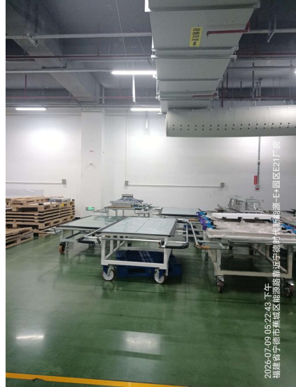
12#CT 检测区正下方
