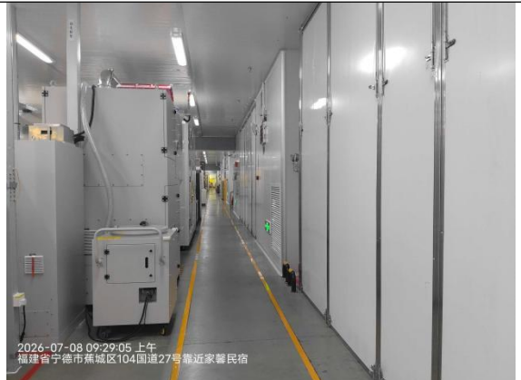
3#和 4#CT 检测区西侧过道
