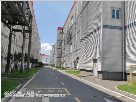
Q1 厂房东侧道路及 Q2 厂房
