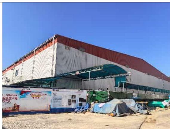
E1 厂房北侧 E6 厂房
