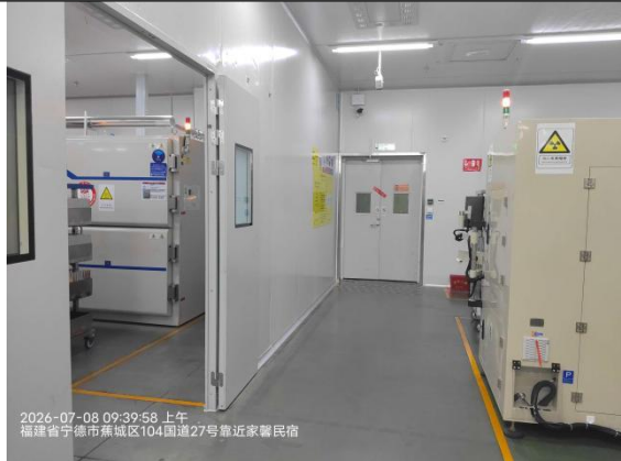
2#CT 检测区北侧过道及干燥房
