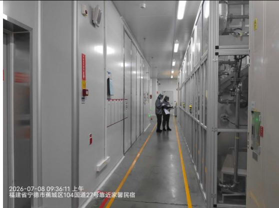
6#CT 检测区西侧过道
