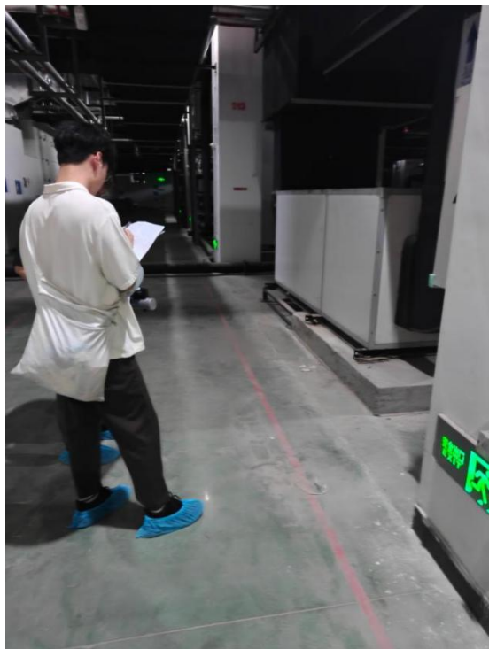
14#CT 检测区正下方
