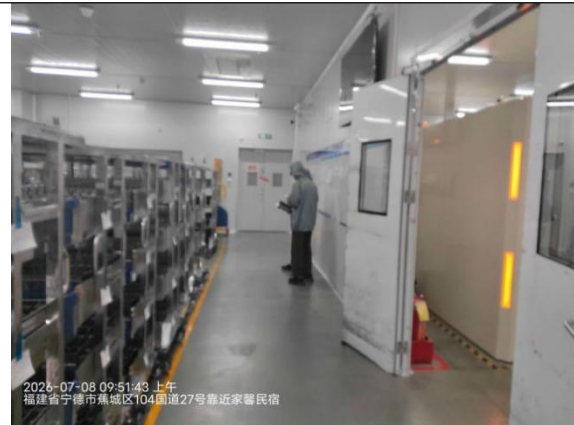
1#CT 检测区北侧过道及干燥房
