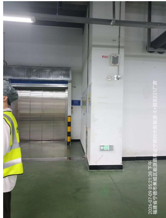
13#CT 检测区正下方
