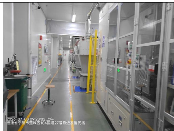
5#CT 检测区西侧过道
