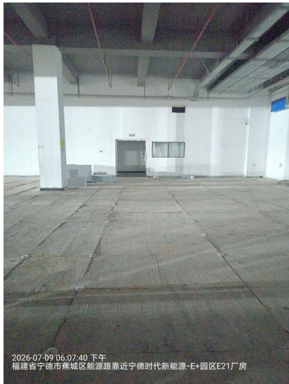
13#CT 检测区现状
