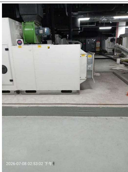
14#CT 检测区正上方
