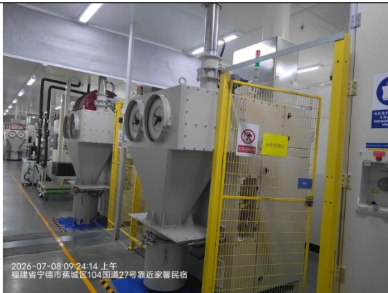
5#CT 检测区现状
