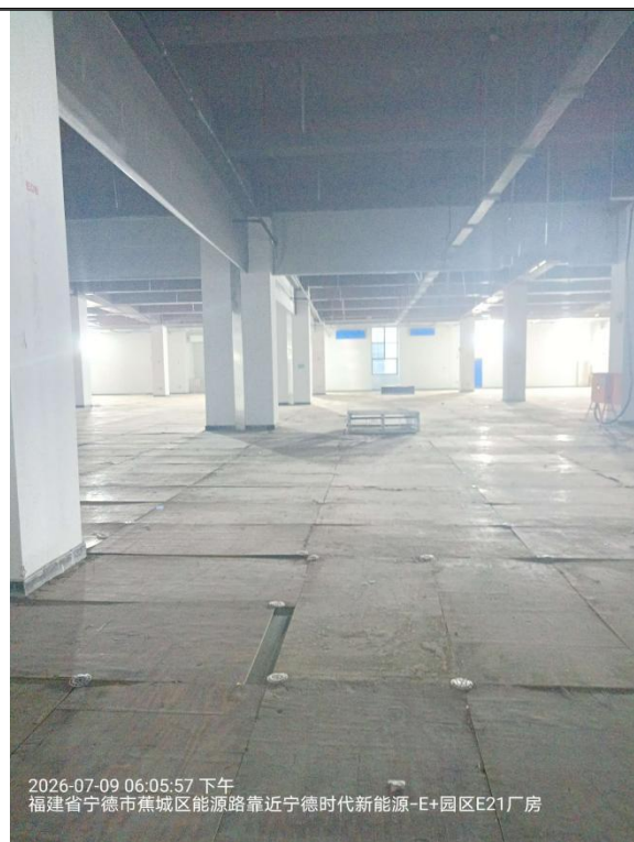
10#CT 检测区现状
